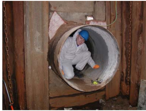
Bild 2: Befahren der Rohrleitung
