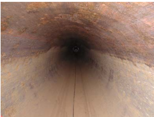
Bild 3: Rohrleitung vor Sanierung
